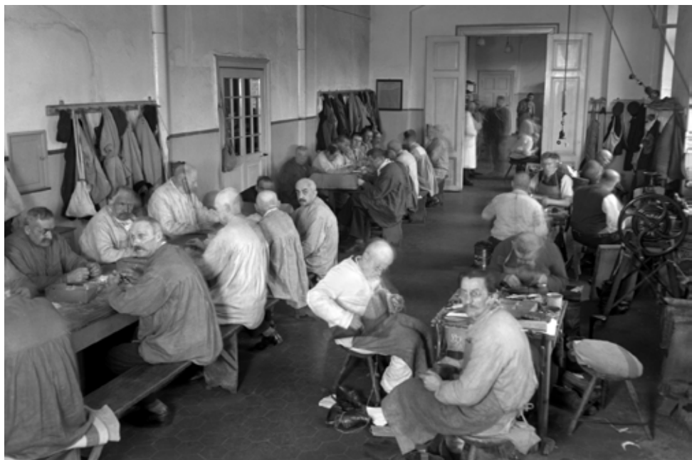
Innenaufnahme Arbeitshaus Rummelsburg, um 1925. Museum Lichtenberg
